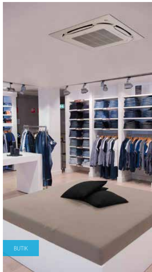
Rundblåsande kassett: 360° luftutblås för optimal verkningsgrad och komfort
