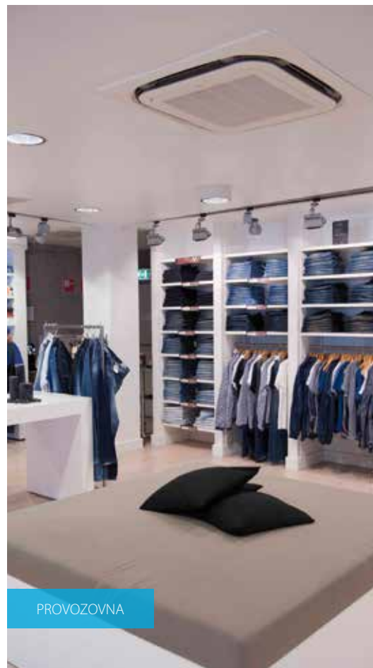
Kazetová jednotka s kruhovým výdechem FXFQ-A: Optimální účinnost a pohodlí dosahované výstupem vzduchu v úhlu 360°
