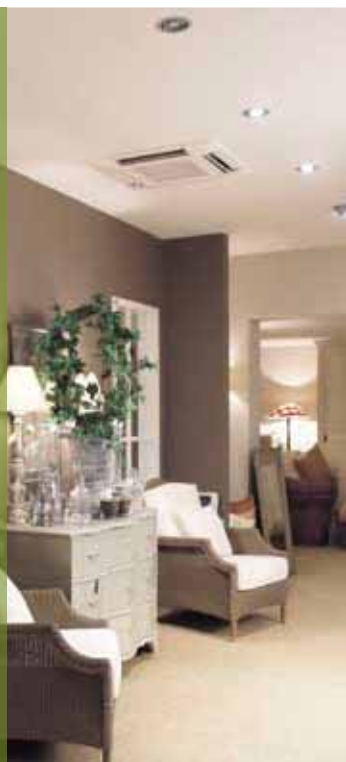
Unidades de cassette de 4 vías para montaje en falso techo (600 x 600 mm)
