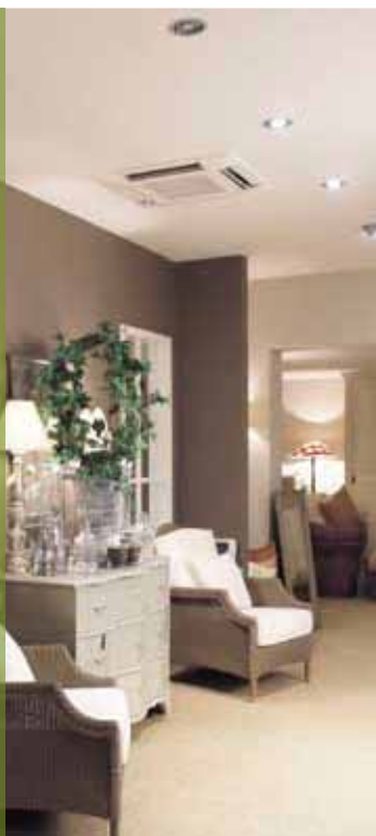
Кассетный 4-поточный потолочный блок (600 x 600мм)
