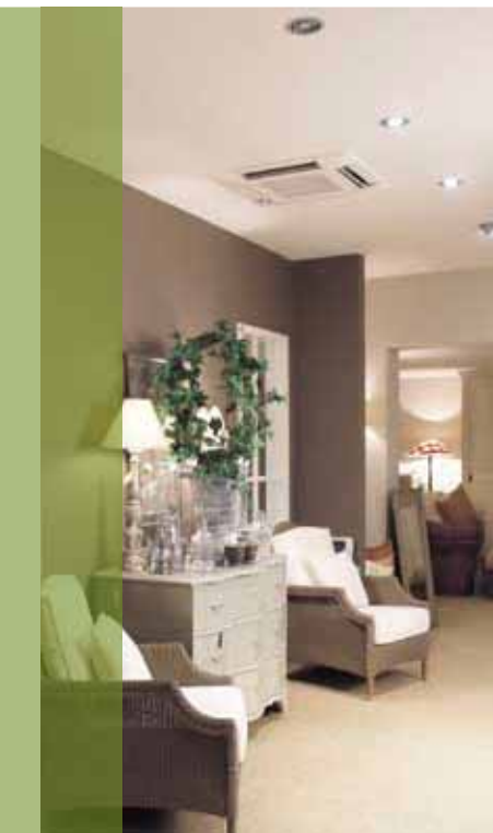
Cassette encastrable à 4 voies de soufflage (600 x 600 mm)
