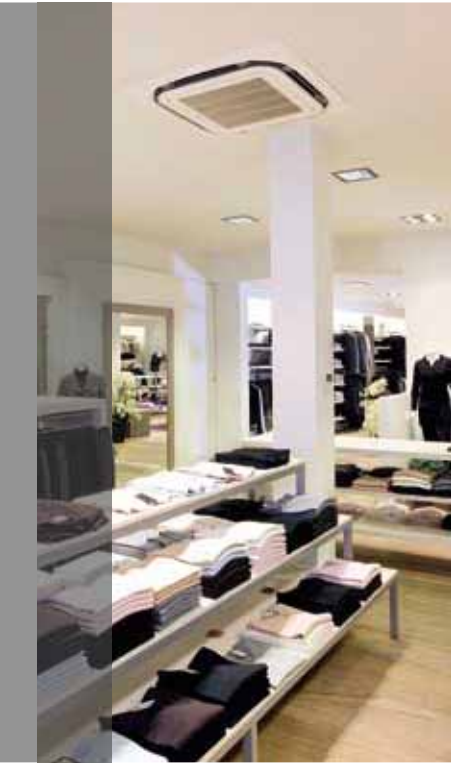
Rundumstrom-Zwischendeckengerät mit hohen COP-Werten
